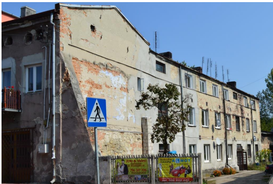
Zdjęcie 11. Stan niektórych budynków w pobliżu Rynku w Działoszycach
