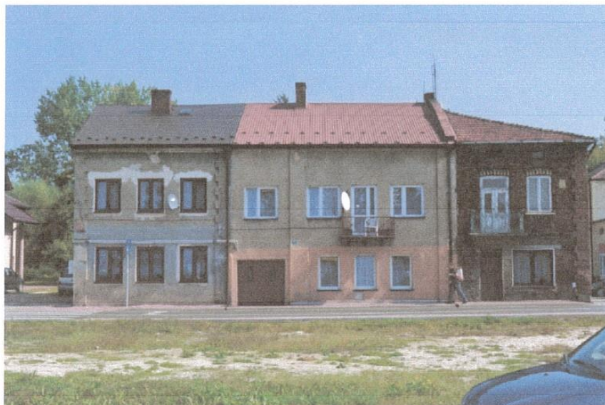
Zdjęcie 8. Stan niektórych budynków w Działoszycach
