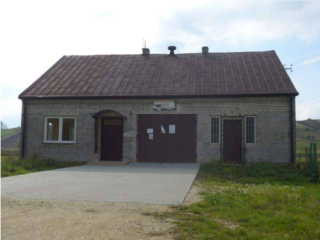
Zdjęcie 24: Budynek Ochotniczej Straży Pożarnej w Bronocicach - fot. GRACZKOWSKI DOTACJE Sp. z o.o.
