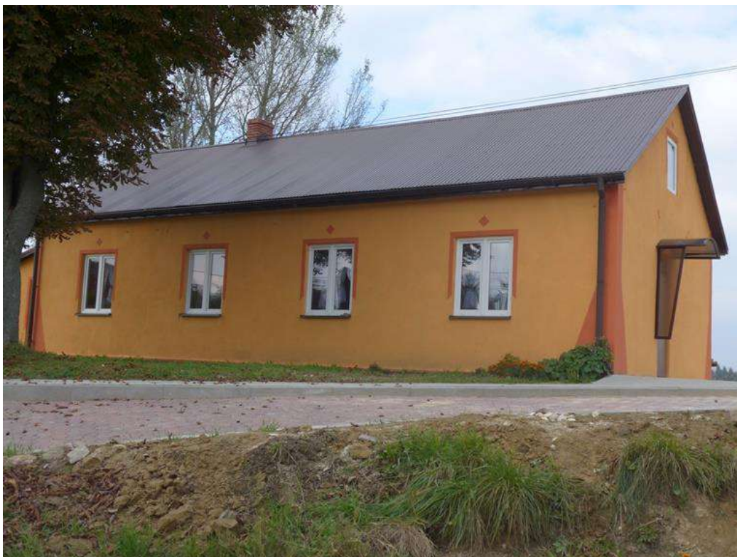
Zdjęcie 42: Budynek świetlicy Wiejskiej w Kujawkach - fot. GRACZKOWSKI DOTACJE Sp. z o.o.
