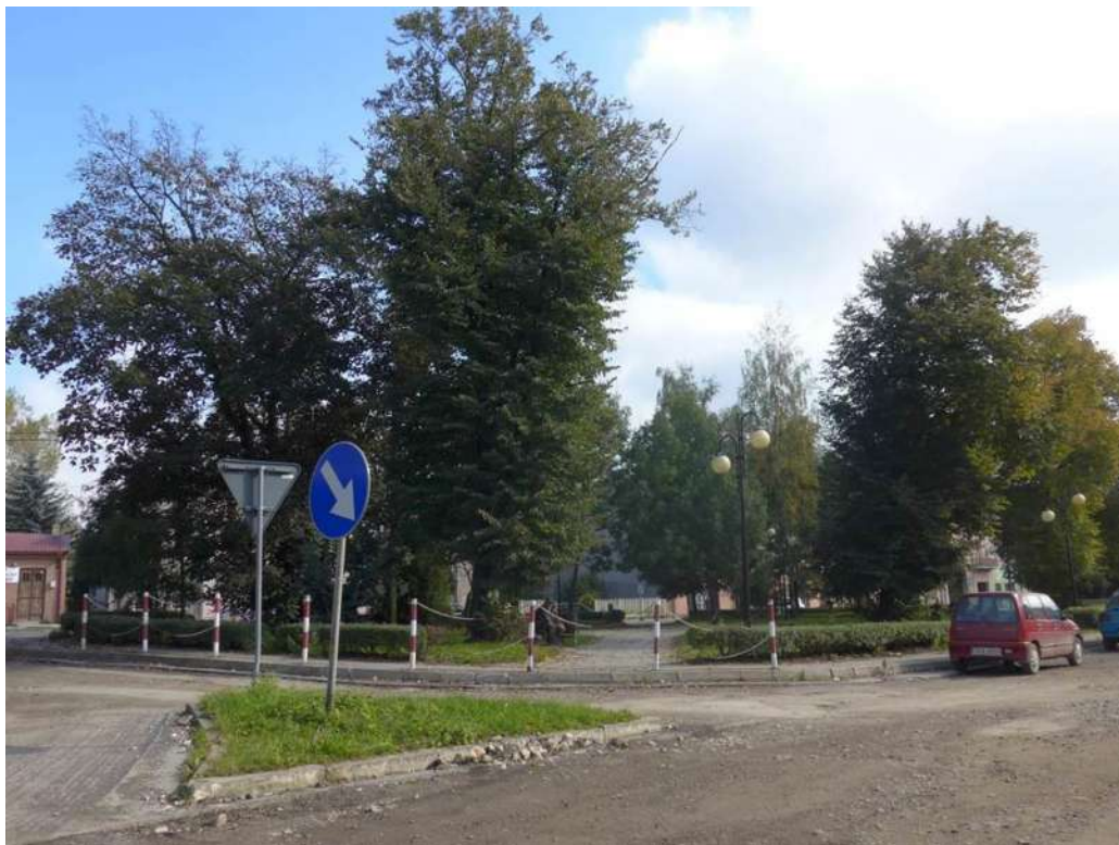
Zdjęcie 49: Rynek w Działoszycach w trakcie prac remontowych (wrzesień 2014r.) fot- GRACZKOWSKI DOTACJE Sp. z o.o.
