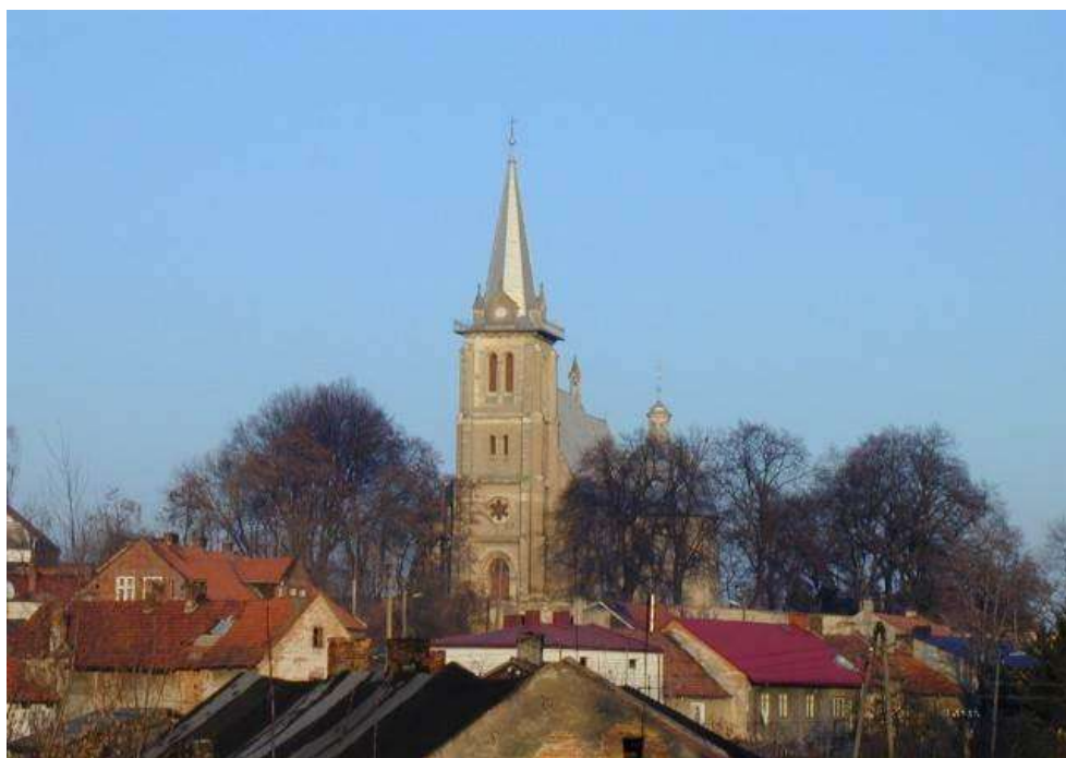
Zdjęcie 53: Wieża Kościoła św. Trójcy widok z boiska KS "Świt"
