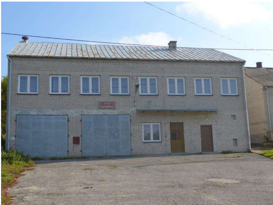
Zdjęcie 47: Budynek Ochotniczej Straży Pożarnej w Opatkowicach – fot. GRACZKOWSKI DOTACJE Sp. z o.o.
