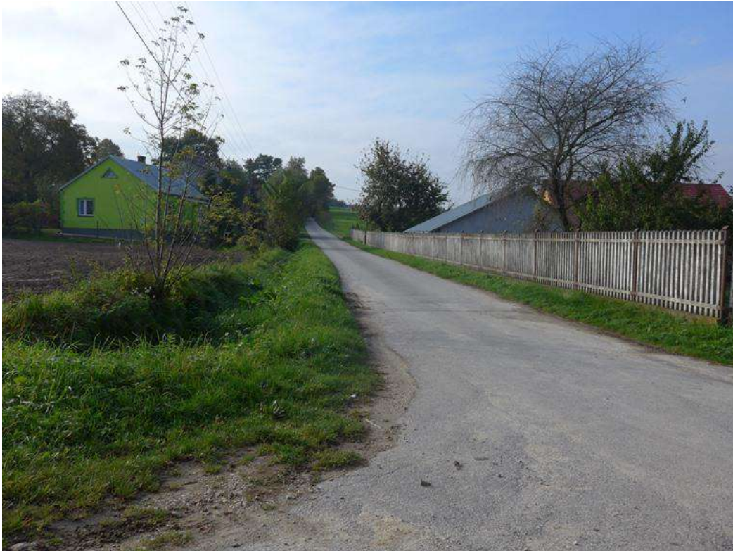
Zdjęcie 38: Droga w miejscowości Dziewięczyce – fot. GRACZKOWSKI DOTACJE Sp. z o.o.
